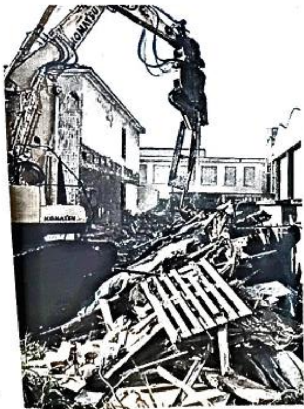
LE DEMOLIZIONI A carico dell'operatore l'abbattimento degli stabili presenti
